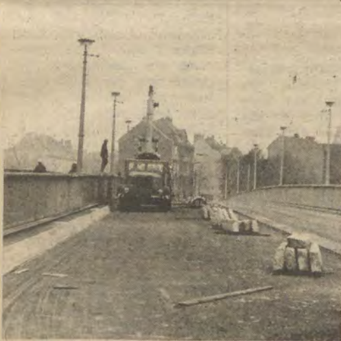
Seit Anfang Oktober rollt der Straßenbahnverkehr wieder über die Treskow-Brücke in Richtung Bahnhof Schöneweide. Derzeit wird noch die linke Fahrbahn erneuert.
