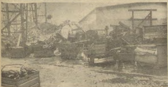
Unweit der Spree wächst ein riesiger Berg Bauschutt in die Höhe. Wie lange noch? Er gehört übrigens dem T-Bereich.
