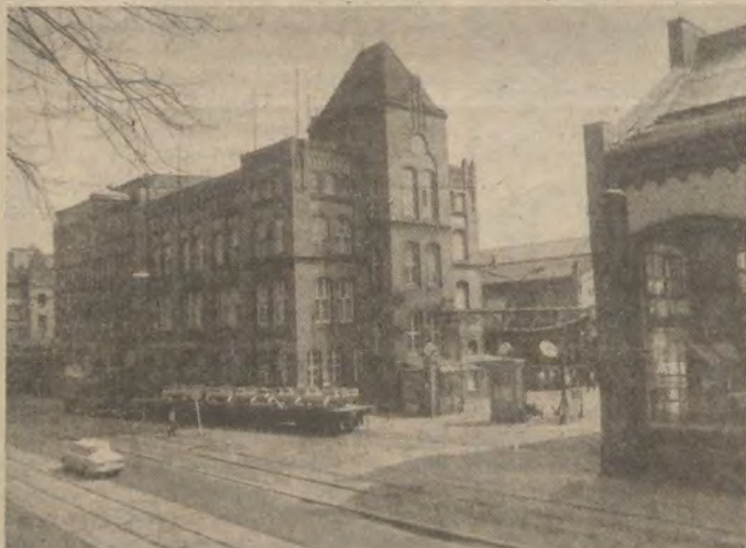
Oberschöneweide heute: Blick auf unser Transformatorenwerk „Karl Liebknecht“.
