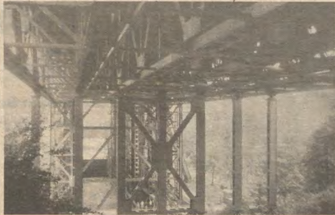
Schiffshebewerk Niederfinow: Blick von unten auf die Kanalbrücke (Bild oben). Der Trog in einer mittleren Position – links gut erkennbar die mächtigen Seile (Bild Mitte)
