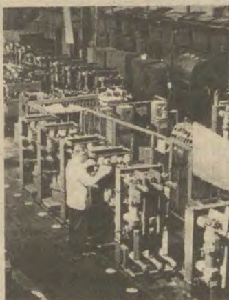
Blick in die Produktionsstätten unseres sowjetischen Partnerbetriebes Saporoshtransformator.
