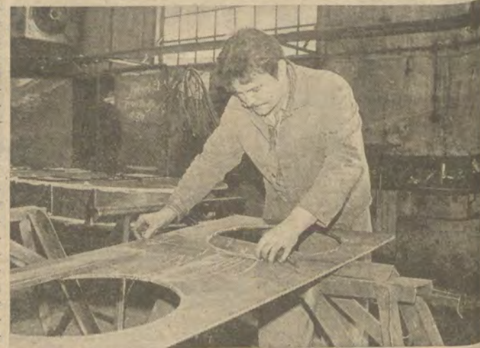
Kollege Peter Schaub aus dem Brückenkastenbau beim Anreißen der Teile für den Deckel.
