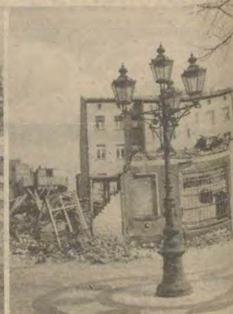
Köpenicks älteste Gaststätte – so sagt's die Geschichte –, die Marktbörse, wurde nun endgültig abgerissen. Nur noch die alte Straßenlaterne erinnert an ihren einstigen Standort. Aber sie soll wieder aufgebaut werden.
