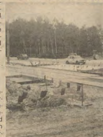
Die Straßenbauarbeiten am Anschlußstück Salvador-Allende-Straße-Müggelheimer Damm gehen weiter voran. In den letzten Tagen wurde der Teil zwischen den Straßenbahnschienen und dem Müggelheimer Damm betoniert.
