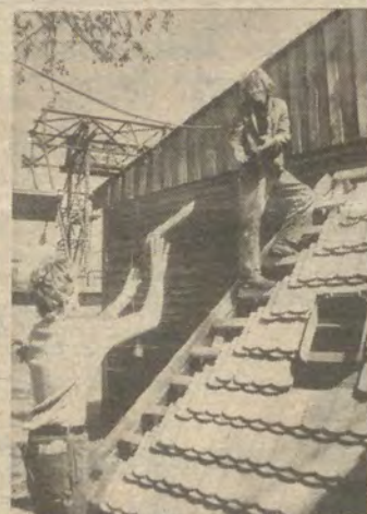
Übung macht den Meister: Dachdeckerlehrlinge am Übungsplatz auf dem Gelände der Lehrwerkstatt.
