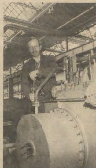
Jürgen Keller arbeitet als Schlosser im Mitteltrafo-Bau. Die erhöhten Aufgabenstellung in Mtr für den Monat August erforderte in der Endmontage dieses Bereiches besondere Aktivitäten. Neben der Produktion von fünf BoBo-Loktrafos, zwei CoCo-Lokreparaturen und einer 16 2/3-Reparatur wurden zwei CoCo-Lokreparaturen und die Bereitstellung von 50 kVA-Trafos zusätzlich realisiert. Damit leistete Mtr einen entscheidenden Beitrag zur Planerfüllung des Transformatorbaues. Hieran hat Kollege Keller wesentlichen Anteil. Besonders zu erwähnen ist sein Einsatz an fast allen Wochenenden des Monats August.
