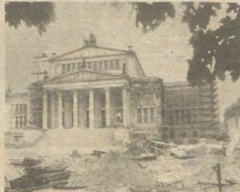
Am Vorabend unseres 35. Republikgeburtstages konnte das im alten Stil wiedererbaute Schauspielhaus am Platz der Akademie in Berlin der Öffentlichkeit übergeben werden. Hier noch zur Zeit der Bauarbeiten im Juli '84.
