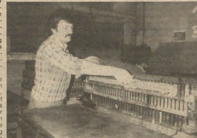
Die Fertigung von Leistengitter für das Loktrafoprogramm und die Kooperation mit TuR Dresden gehört zu den wichtigen Aufgaben in der Geax. Auf unserem Foto Kollege Roland Florke.
