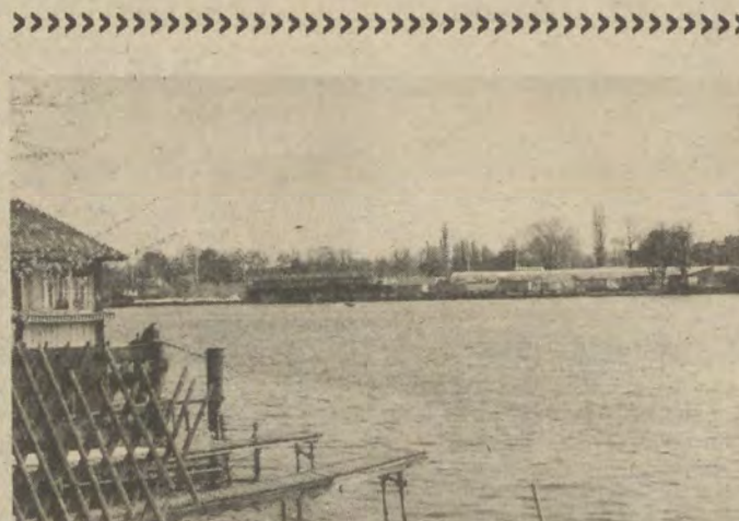
Keinesfalls Frühgemüse wird unter diesem Foliengelt angebaut. Dieser lange Schlauch an der Köpenicker Dammbücke dient der Spanngliedervorfertigung für den Brückenbau. Die Spannglieder, die zu einem Teil von etwa 65 Meter Länge montiert werden, dürfen nicht rosten. Sie werden als ein Stück über die Spree gezogen und bilden für die künftige Spannbetonwölbung eine Art Gerippe.
