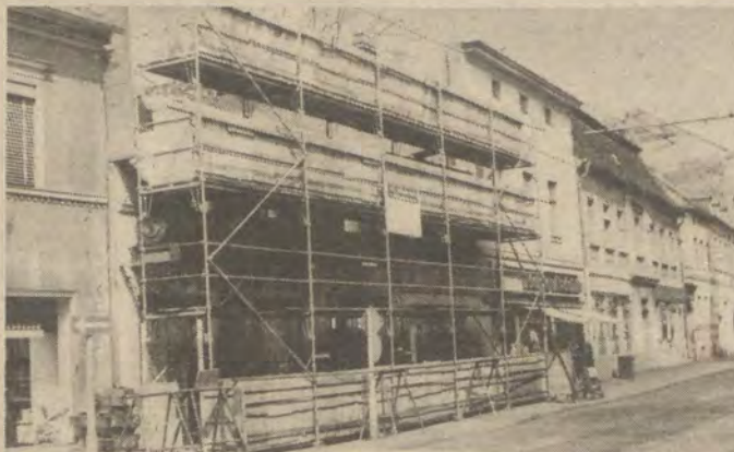
Beachtliche Ergebnisse konnten auch im Köpenicker Bauwesen abgerechnet werden. Dazu gehören 155 modernisierte Wohnungen und drei fertiggestellte Häuser in der Köllner Vorstadt.
