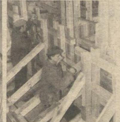
Bild 9: Schalung des Fundamentes.
