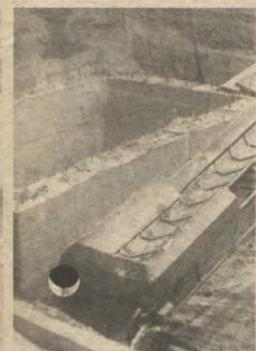
Bild 4: Der Senkkasten, der später das Becherwerk aufnehmen soll, ist auf einem Niveau von -2 m gegründet.
