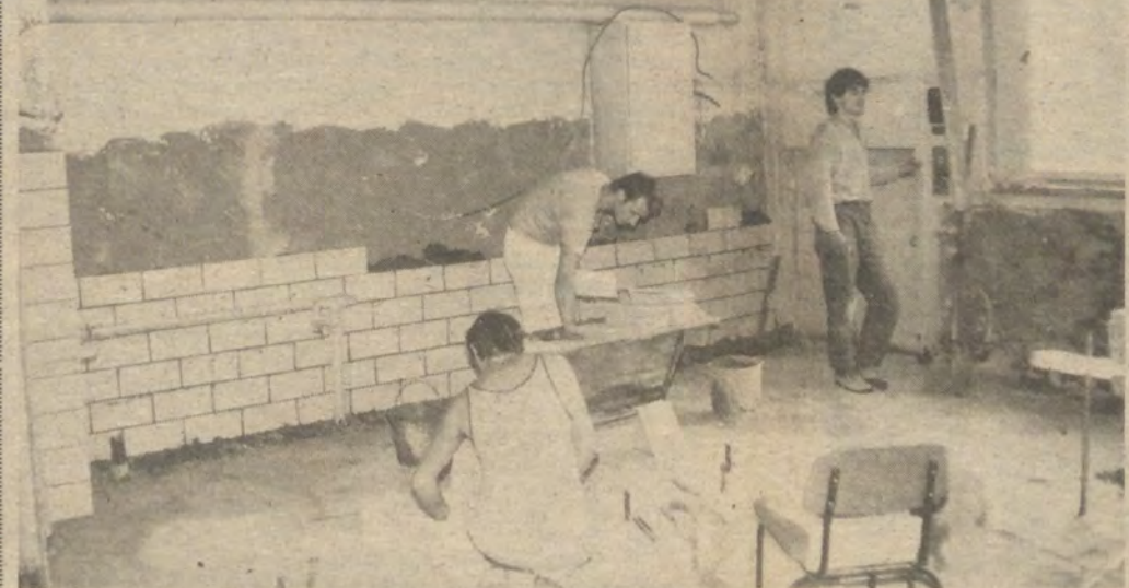
Im Juni haben die Rekonstruktionsmaßnahmen der Küche und des Speisesaals in Rummelsburg begonnen.
