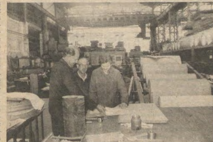
Zwar liegt auch noch heute vieles herum in dem Arbeitsbereich der Preßspanbrigade, dennoch kann man von großer Ordnung und Sauberkeit reden, weil die Systematik wohl unübersehbar dabei für Außenstehende ist.
