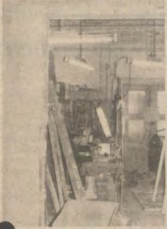
Die Schallschutzmauer im Modellbau, die unsere Maurerlehrlinge kurzfristig realisierten, trägt zur Verringerung der Lärm- und Staubbelastung bei.
