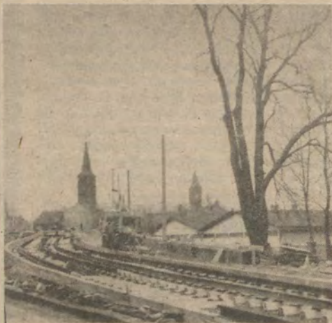
Die neue Dammbrücke gewinnt von Tag zu Tag mehr an Gestalt. Seit einigen Wochen werden neue Gleise für die Straßenbahn verlegt, die Anschlußarbeiten vorgenommen.
