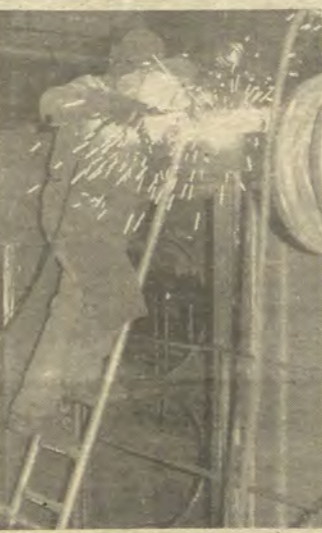
E. Schweißer im Behälterbau ist Kollege Detlef Breithor.
