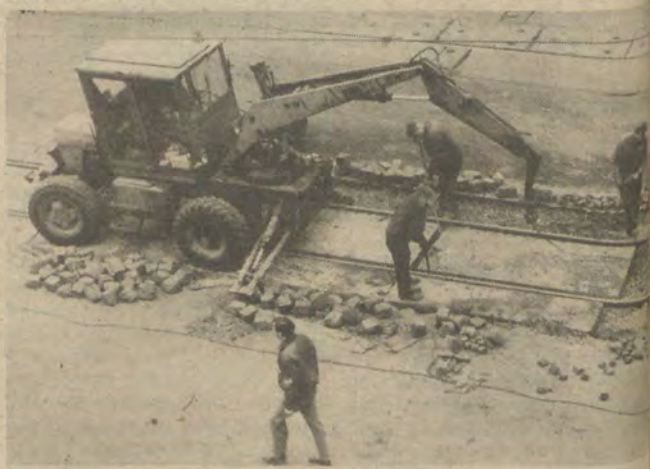
Ausgewechselt wurde in der vergangenen Woche – viele TROjaner werden es sicher bemerkt haben – das Hauptgleis für die Oberschöneweider Betriebsbahn direkt vor unserem Betrieb. Die Gleisanlagen gehören zum VEB Binnenhafen Berlin.
