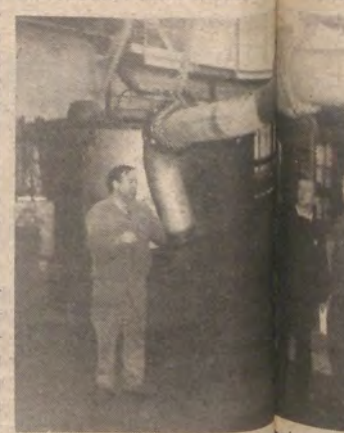
Rohrleitungen am Trafo gehören zu den Aufgaben der Endmonteure. Einen Eindruck vermittelt dieses Bild.
