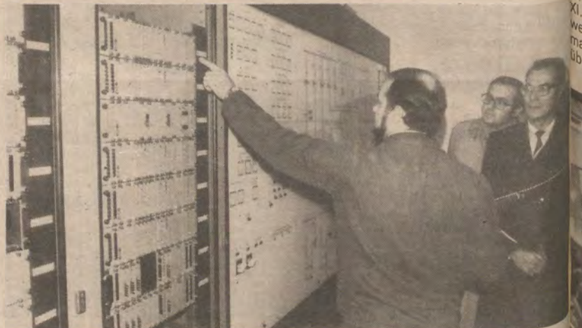
Am 22. Januar 1985 wurde das Vorhaben „Rekonstruktion des Transformatorfeldes“ zu unserem Parteitagobjekt erklärt. Durch die hohe Einsatzbereitschaft beteiligten Bau- und Montagekollektive konnte drei Monate vorfristig der neue generator seine Arbeit aufnehmen.
