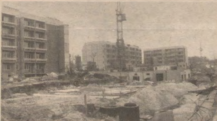
Eine der vielen Baustellen in unserer Hauptstadt: die Müggelheimer Straße, Köpenick. Nach Fertigstellung der Köllnischen Vorstadt sind die jungen Erfurter Bauleute jetzt bemüht, bis zum Jahresende den Köpenickern hier über 400 neue Wohnungen übergeben zu können.
