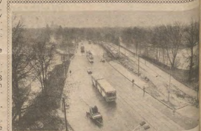
Sie hat sich inzwischen schon bestens bewährt, die neue, 63,5 Meter lange und 19 Meter breite Dammbücke am Zusammenfluß von Spree und Dahme in unserem Köpenick. Insgesamt sieben Straßenbahnlinien mit 32 Fahrten und zwei Buslinien mit 12 Fahrten passieren sie stündlich.
