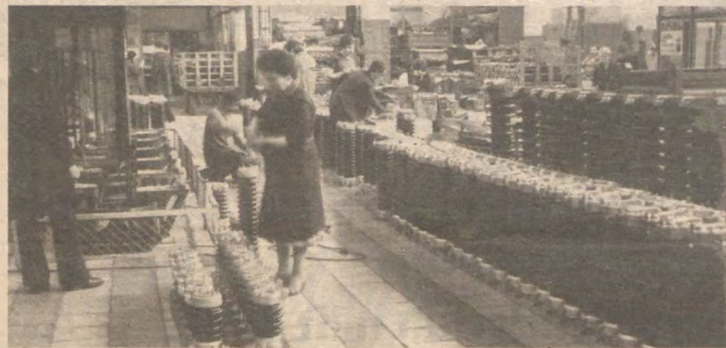
Im Werk Przasnysz werden die Ableiter montiert.
