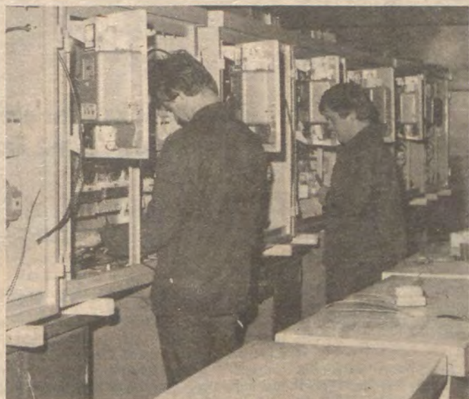
Ein Schnappschuß aus der Montagehalle. Hier werden Verteileranlagen RD1 montiert.
