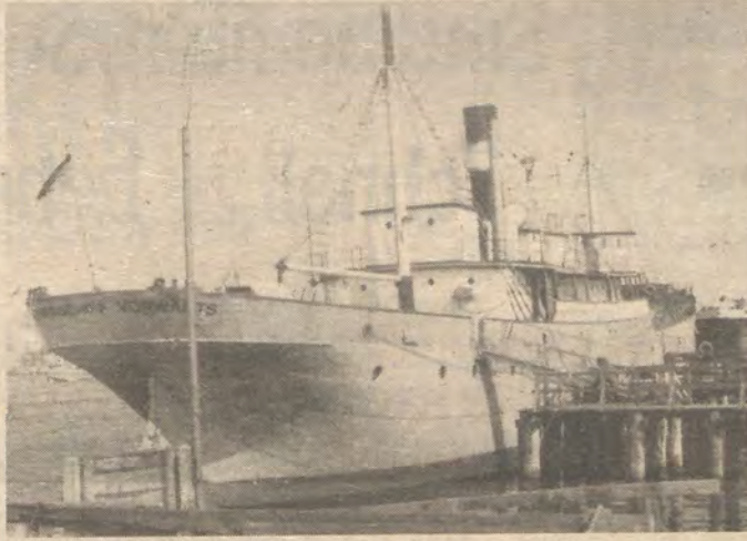
Das Hauptdeck des Traditionsschiffes mit einem Teil der Ladebäume, die bei 15 m Ausladung drei bis sechs Tonnen heben konnten. Im hinteren Teil des Schiffes ist auch ein Jugendtourist-Hotel mit 66 Betten und eine Sporthalle untergebracht (unser Foto links oben). Das heutige Pionierschiff „Vorwärts“ war das erste Hochseehandelsschiff der DDR und wurde bereits 1903 in Rostock gebaut. Es ist nicht am Traditionsschiff sondern am Kabutzenhof festgemacht (Foto rechts oben).
