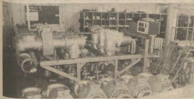
Ein Blick in die GSAS-Fertigung. Gemeinsam mit ES und N realisieren die Außenmonteure die Vorziehung eines volkswirtschaftlich wichtigen GSAS-Objektes vom 31. auf den 7. Oktober.
