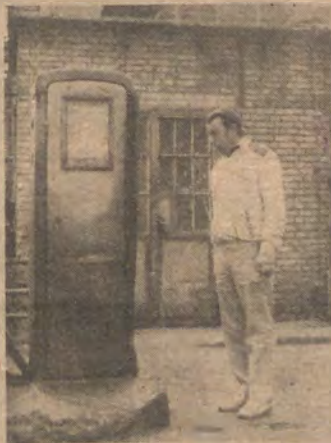
Diese alte Zapfsäule ist nicht nur sehr unansehnlich, sondern verliert täglich einige Liter Dieselmotorkraftstoff. Es wird höchste Zeit für die neue Zapfsäule!
