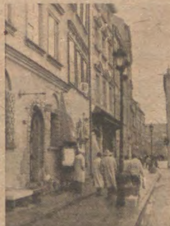
würdigen, denn auch das älteste Bauwerk ist erst 45 Jahre alt.
