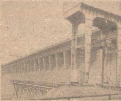
Das Bratsker Wasserkraftwerk zählt zu den größten der Erde. Auf der 127 m hohen Dammkrone überquert die Eisenbahn die Angara. Wenige Meter darunter gibt es eine zweispurige Autostraße.
