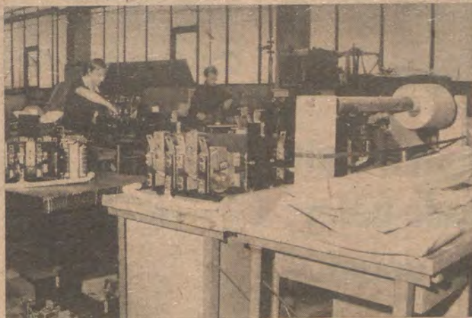
Blick in die Stufenschalterfertigung im Betriebsteil Rummelsburg.
