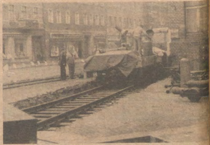
Die bereits rund 50 Jahre einliegenden alten Anschlußgleise unserer Werkbahn werden in diesen Tagen erneuert. Viele von unseren TROjanern konnten diese Arbeiten verfolgen, die im wesentlichen vom Gleisbaubetrieb der Deutschen Reichsbahn Berlin Köpenick durchgeführt werden. Die Anschlußarbeiten, wie die Pflasterung des Fußgängerbereiches, werden in Eigenleistung durch unseren Betrieb ausgeführt.
