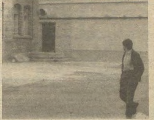
Die Mauer zur Fischräucherei hat jetzt ein wesentlich freundlicheres Aussehen, dank der Arbeit der Bauleute zum Ende des Jahres. Doch nicht nur um das Aussehen ging es, sondern die Instandsetzung war eine wichtige Forderung von LI.
