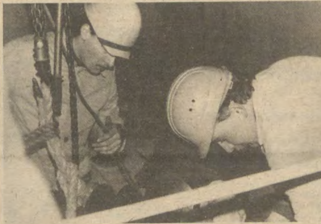
Karsten Hammer (links) und Henry Klein beim Anschluß der Trafodurchführungen an die GSAS-Anlage. Vorsicht ist auch hierbei die „Mutter der Porzellankiste“.
