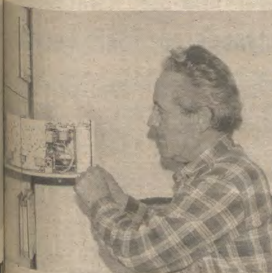
Volker Eger arbeitet im Bereich des Großtrafoprüffeldes.
