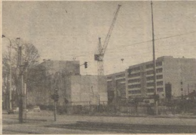
Zügig voran gehen die Bauarbeiten an der Grünen Trift/Kietzer Vorstadt.
