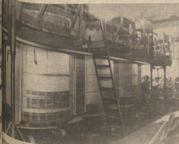
Während in der Endmontage und im Prüffeld noch an der Fertigstellung des 250 B Nr. 1 gearbeitet wurde, bauten die Spulenaufbereiter bereits das Aktivteil für das Gerät Nr. 2 auf.
