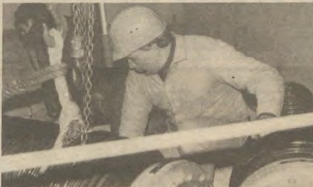
Unter überaus komplizierten Bedingungen geht die Montage der GSAS-Anlagen vonstatten. Präzision ist hier in jeder Minute gefragt.
