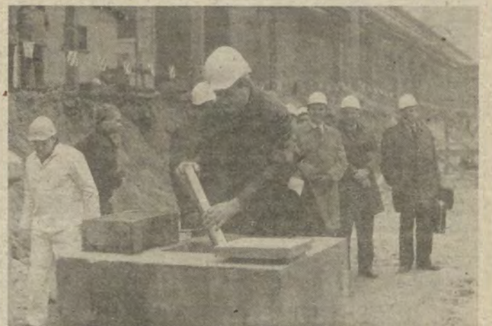
Noch jüngste Geschichte: die Grundsteinlegung für das Mehrfunktionsgebäude im Rahmen der komplexen Rekonstruktion des TRO
