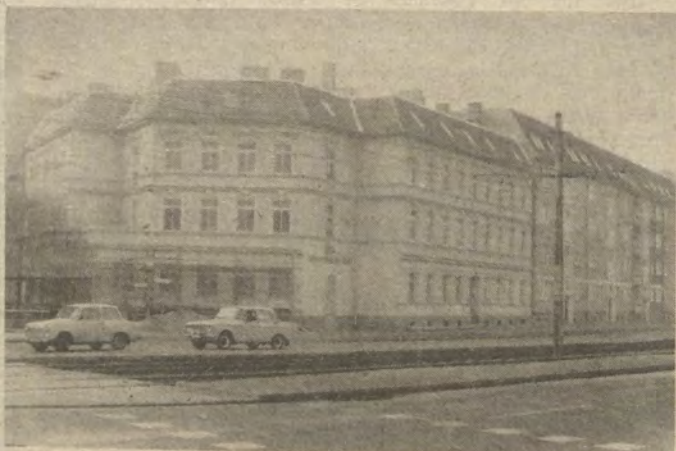
Eine ganze Straße entstand in den letzten Jahren neu: die Müggelheimer in Köpenick.
