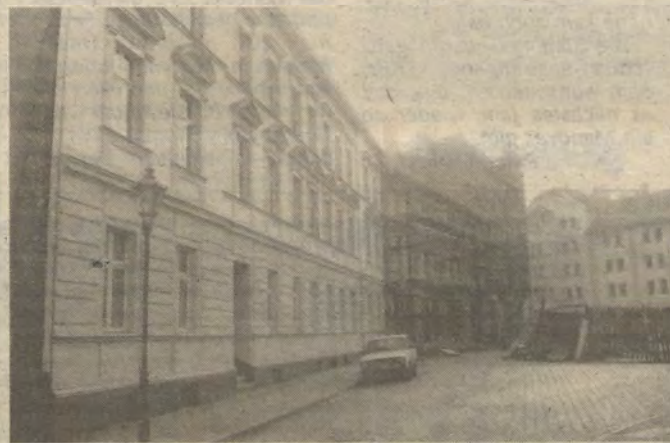
Umbau in der Altstadt: der Lehrlingsbau am Schüßlerplatz.
