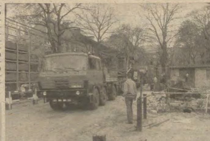
Millimeterarbeit sozusagen war die Auffahrt des Turmdrehkrans für die Montage des Mehrfunktionsgebäudes auf unser Betriebsgelände. Zur Verkürzung der Montagezeiten wird im Sommer ein zweiter hinzukommen. Nach dem Aufbau des ersten Krans erfolgt die Erweiterung des Gleisbettes.
