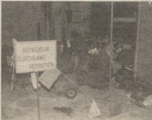
Während der Reparatur und...
