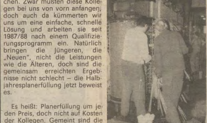
Ein Blick in die Schaltrei des Großtrafoabbaus
