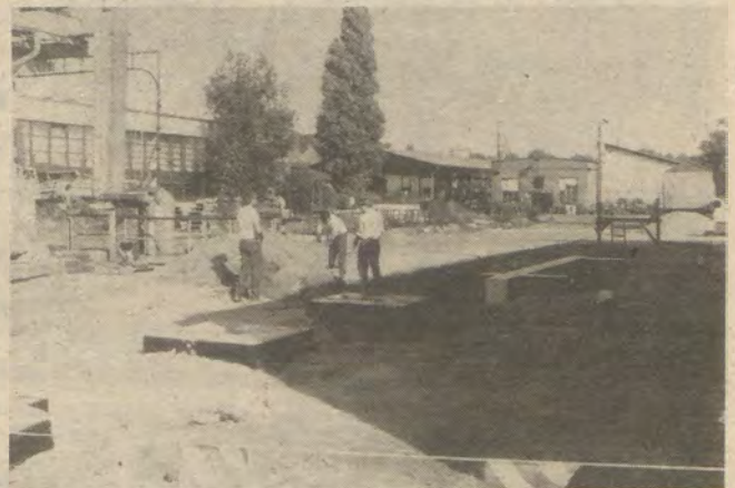
Für die neue Wasseraufbereitungsanlage entsteht am Kesselhaus ein Anbau.
