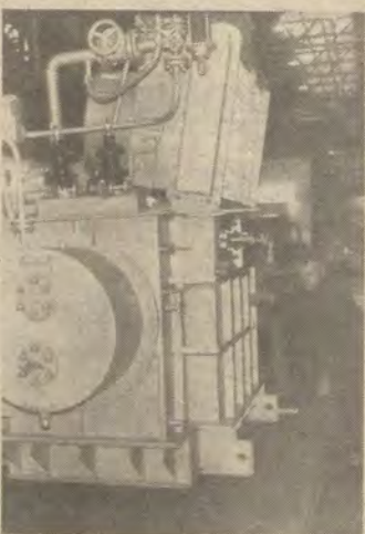
Im vergangenen Monat schafften die Kollegen des Mitteltrafoabbaus wieder einen Loktrafo über den Plan – Ergebnis ihrer Höchstleistungsschicht.
