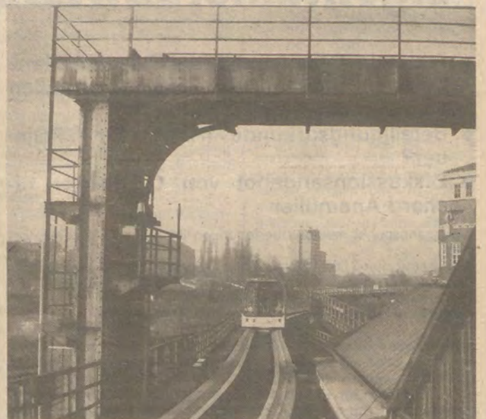
Die Magnet-Bahn bei der Ausfahrt aus dem U-Bahnhof Gleisdreieck. Deutlich sind die alte U-Bahn-Trasse Richtung Potsdamer Platz und eine alte Signalbrücke zu erkennen.
