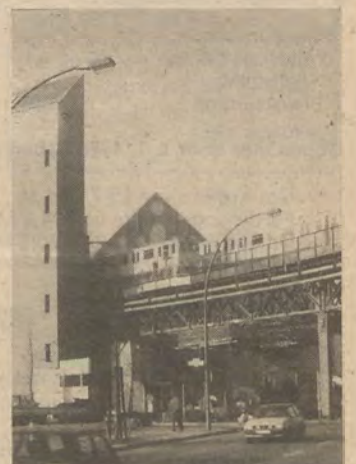
Zwischen Gleisdreieck und Möckernbrücke fuhr die U-Bahn früher durch das Haus hindurch. Hier vor dem Museum für Verkehr und Technik gab es einst vier Verkehrsebenen, von denen drei noch erhalten sind: die U-Bahn, darunter die Eisenbahnbrücke zum Anhalter Bahnhof, die Straße und den Landwehrkanal.
