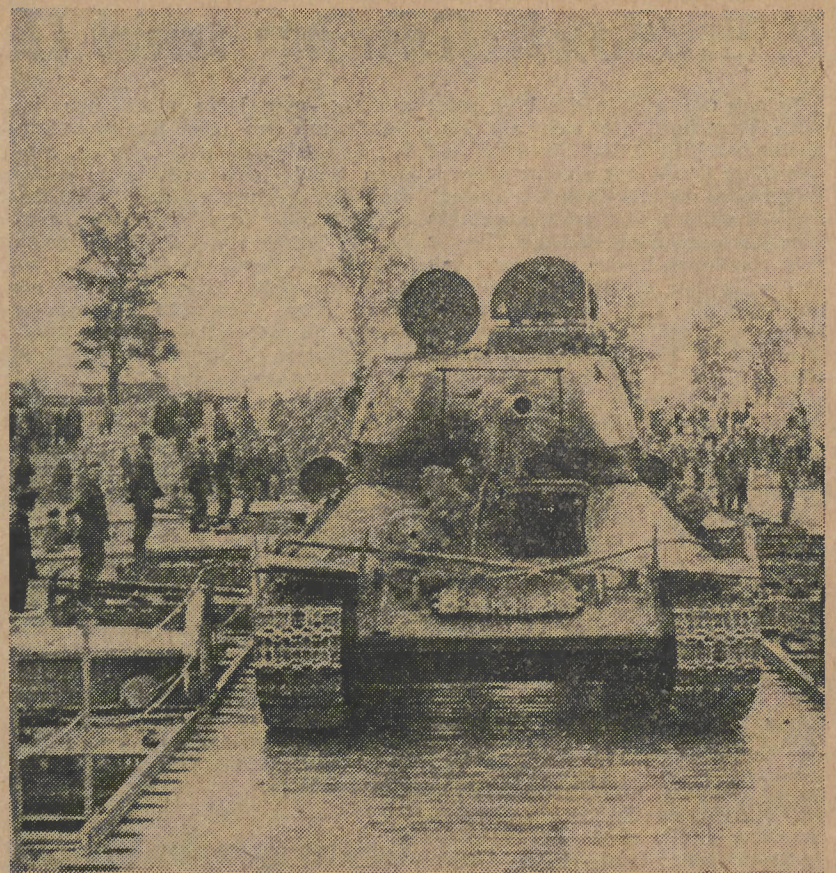
Brückenbau-Pioniere haben während einer Übung eine Pontonbrücke über einen Fluß geschlagen. — Der erste Panzer passiert die Brücke, der Vormarsch kann weitergehen
