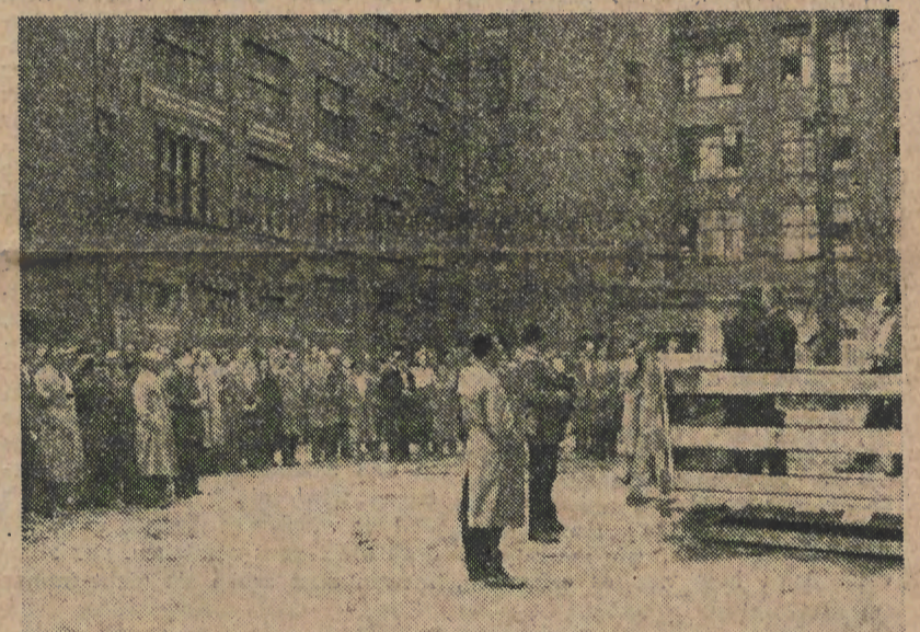
Heute vor einer Woche wurde am Produktionsgebäude unseres neuen Bildröhrenwerkes die Richtkrone aufgezogen
