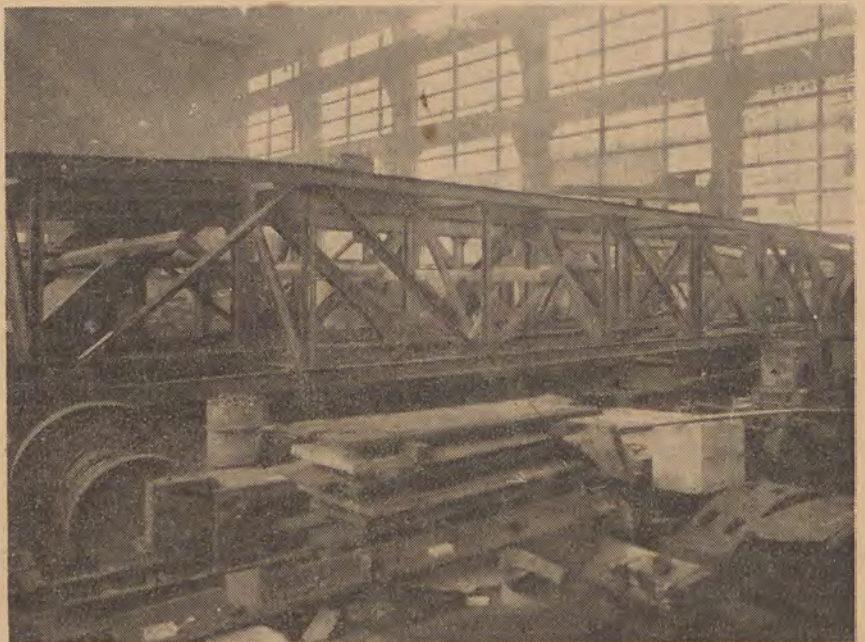
Das wird der neue 100-t-Kran für die Abt. Großtransformatorenbau. Die „Laufkatze“ mit allem Zubehör liefert die Firma DEMAG in Duisburg.
