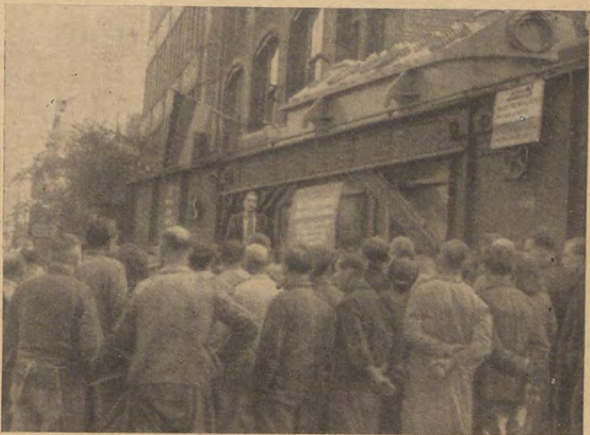
Als Sonderleistung zu den Friedenswahlen wurde die Generalüberholung des 60 000 KVA-Großtransformators für das Industriegebiet bei Zwönitz im Erzgebirge um 10 Tage vorfristig beendet. Bei der Verabschiedung des Trafos hatten sich die Beteiligten zu einer kurzen Feier zusammengefunden, auf der Kollege Willing den Dank der Werkleitung aussprach.
