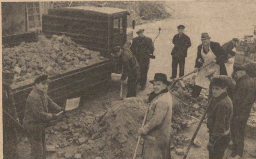
Unsere Kollegen beim Verladen des abgetragenen Schuttes
