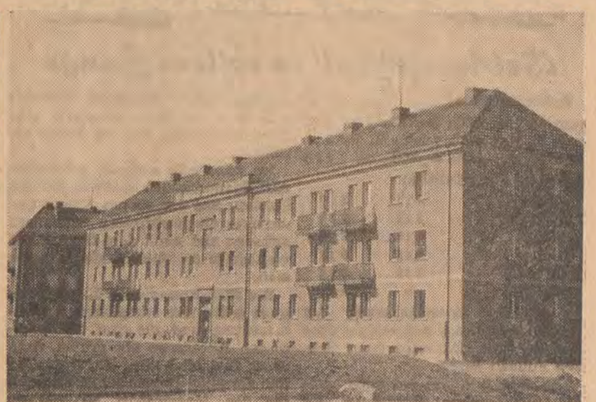
Erster Bauabschnitt der AWG Berlin-Johannisthal, Pilotenstraße
