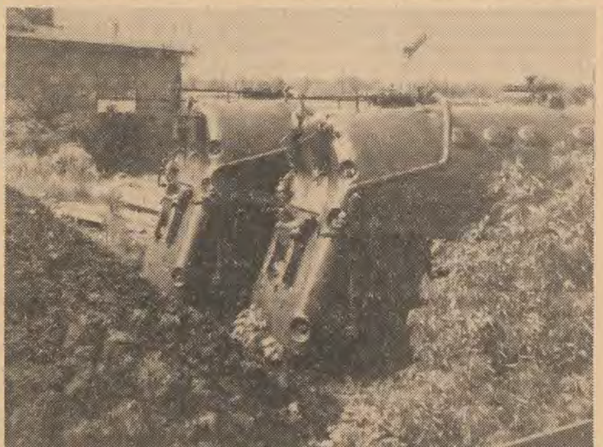
Diese zwei großen Kessel werden ab 1. Oktober in ihren Fundamenten ruhen. Die Maurer halten den Termin nicht nur ein, sondern beenden ihre Arbeiten einige Tage früher. Bis zum 1. Oktober wird ein Kessel voll betriebsfähig sein.
