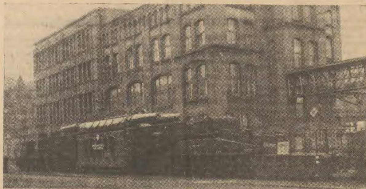
Die im Transformatorenwerk „Karl Liebknecht“ gefertigten Transformatoreneinheiten werden immer größer. Um den Transportanforderungen gerecht zu werden, hat die Reichsbahn in Zusammenarbeit mit der Industrie neue, größere Transportwagen für eine Nutzlast von 240 t angeschafft. — Der Transport eines 100-MVA-Transformators mit einem Transportgewicht von 175 t ging am 27. Januar d. J. von Oberschöneweide ab
